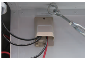
外部電力供給
